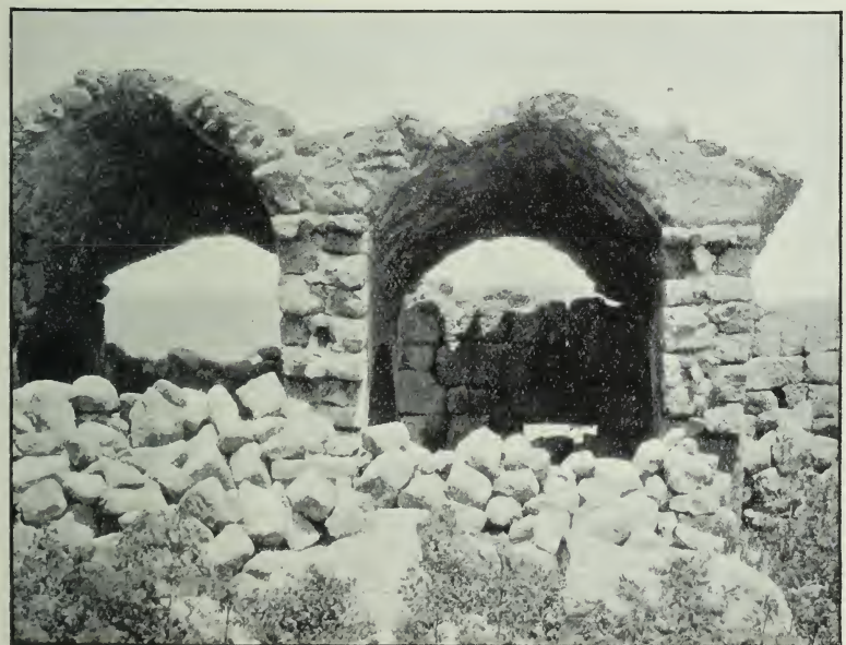
FIG. 33.—No. 6, bays of N. aisle.
